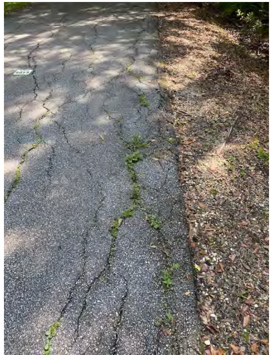
Edge cracks
